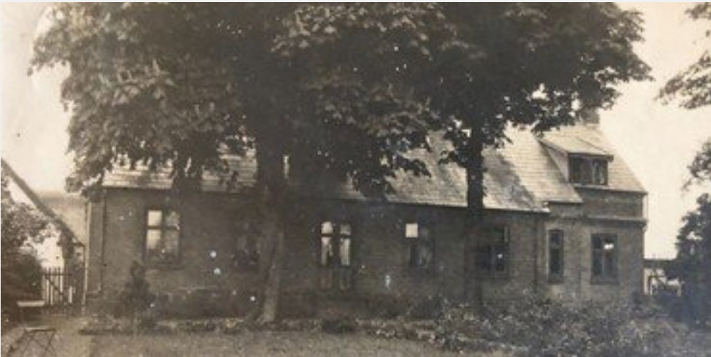
1930erne – Stuehusets udbygning til højre har fået en 1. sal med kvist. De velvoksne træet foran huset måtte snart lade livet.
